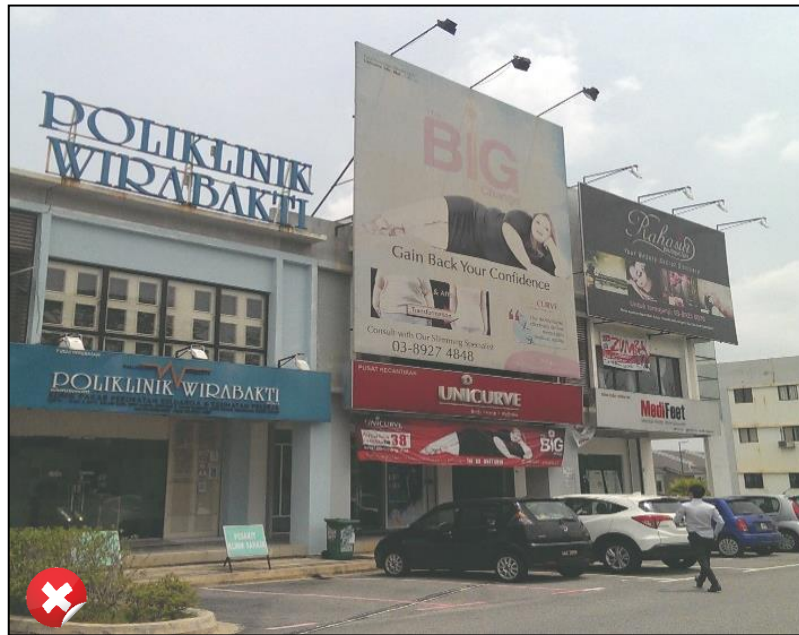
Foto 4: Contoh papan tanda yang dipasang melebihi daripada aras bumbung adalah tidak dibenarkan.
