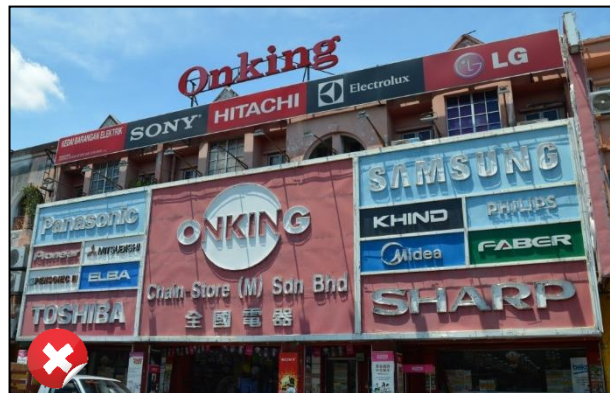
Foto 16 : Papan tanda yang menutupi fasad bangunan adalah tidak dibenarkan.
