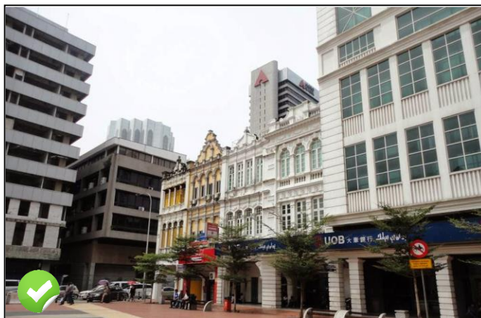
Foto 33 : Pemasangan papan tanda yang tidak menutup fasad bangunan.
