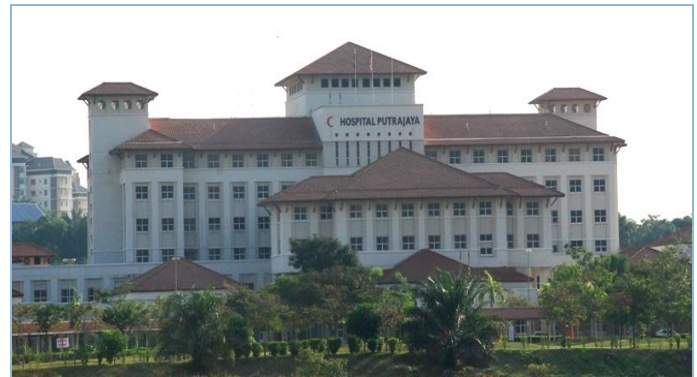
Hospital Putrajaya, Putrajaya. Julai, 2011
