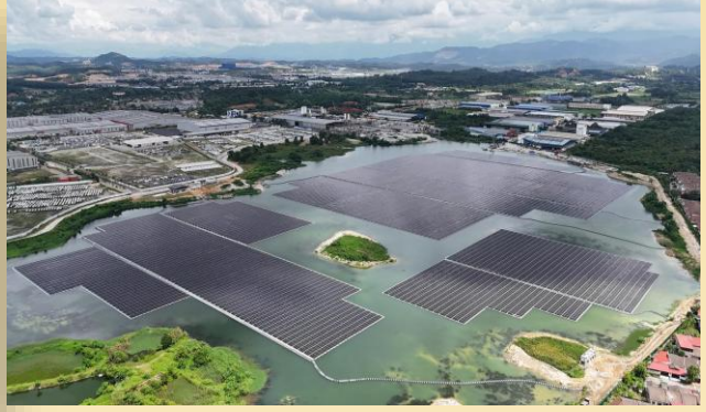
Foto 2: Pembangunan Ladang Solar Atas Air
