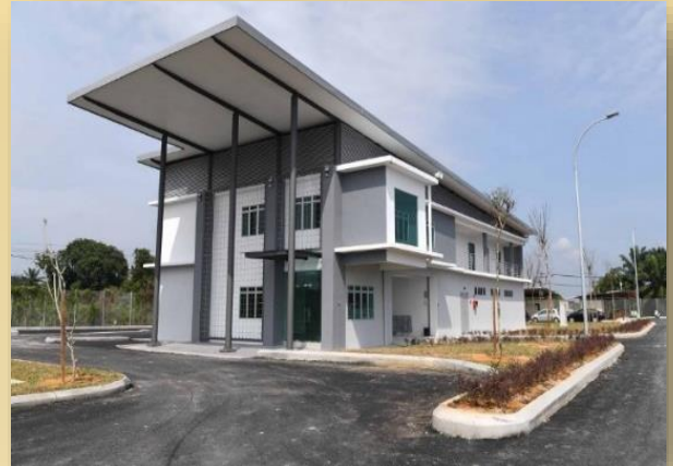
Foto 7: Bangunan sokongan yang dibangunkan di LSS Bidor
