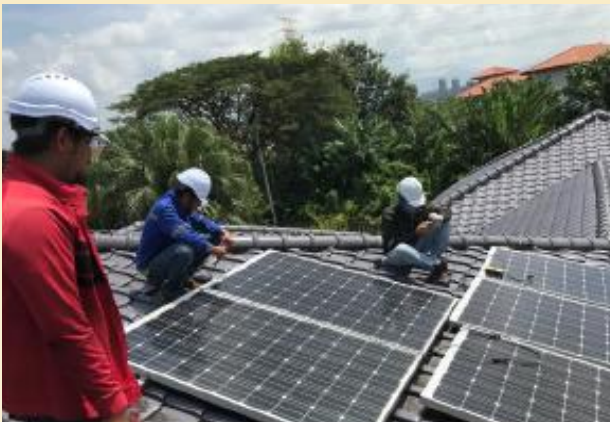
Foto 22 : Contoh PV dipasang mengikut rekabentuk dan tidak melebihi paras tertinggi atau tepi bumbung bangunan
