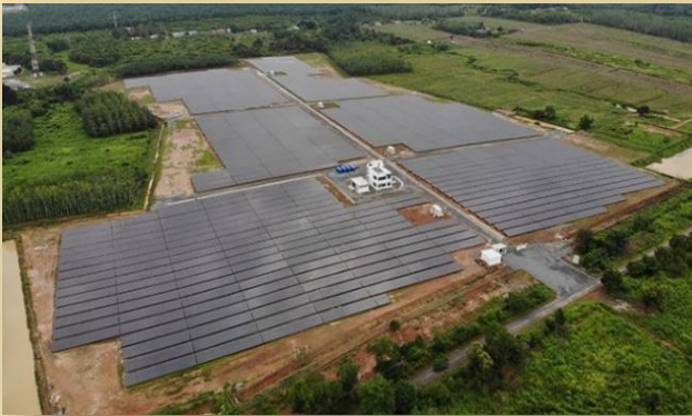
Foto 1: Pembangunan Ladang Solar Atas Tanah
