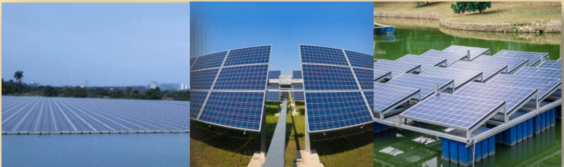
Foto 5 : Panel PV yang boleh dipasang atas tanah dan terapung atas air
