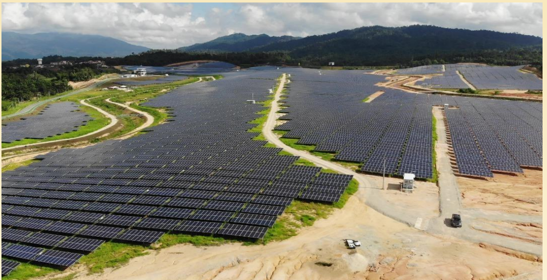
Foto 18: Pembangunan ladang solar di kawasan rata dan landai memaksimumkan kadar penyerapan cahaya matahari
