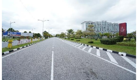
Jalan Protokol di sepanjang Jalan Anak Bukit
