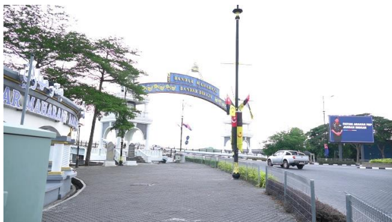
Pintu Gerbang di Jambatan Sultan Ismail
