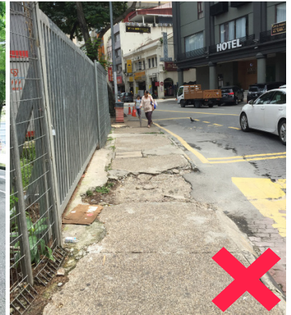
Foto 4.6: Laluan pejalan kaki yang tidak diselenggara dengan baik dan tidak selamat kepada pengguna
