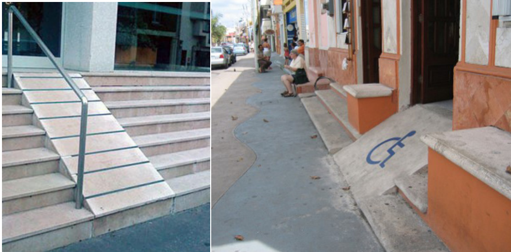
Foto 4.62: Landas angkat yang terlalu curam untuk pengguna
