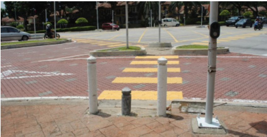
Foto 4.66: Tonggak jalan menghalang laluan bagi pengguna kerusi roda
