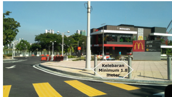
Foto 4.21: Penyediaan lintasan zebra dengan ciri-ciri keselamatan dan reka bentuk sejagat iaitu step ramp dan tonggak jalan bagi memudahkan pengguna melintas jalan
