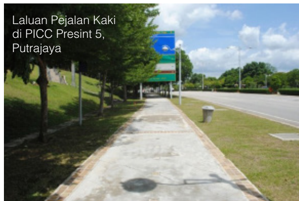
Foto 4.69: Contoh turapan laluan pejalan kaki jenis simen campuran yang lasak, tidak licin dan mudah diselenggara di PICC, Presint 5 Putrajaya
