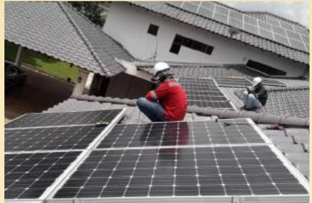
Foto 21 : Struktur Bumbung boleh menampung beban panel solar yang dipasang
