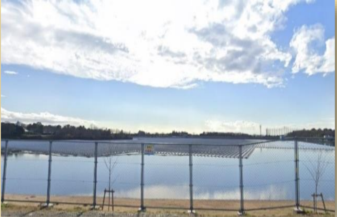
Foto 10: Pagar keselamatan di sekeliling ladang solar atas air di Yamakura, Jepun
