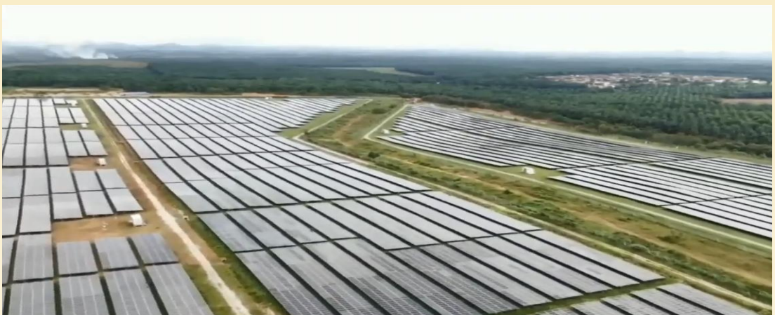
Foto 16 : TNB Bukit Selambau Solar, Stesen Janakuasa Elektrik Solar Fotovoltaik, LSS Bukit Selambau, Kedah
