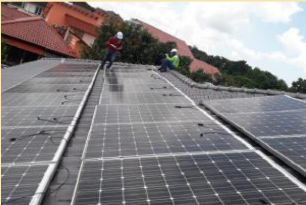
Foto 21 : Struktur Bumbung boleh menampung beban panel solar yang dipasang
