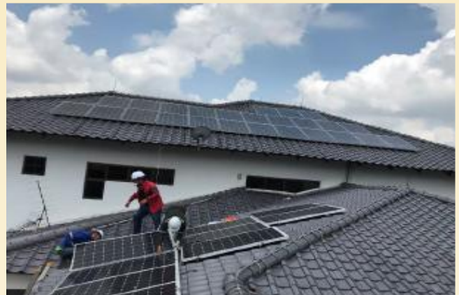
Foto 22 : Contoh PV dipasang mengikut rekabentuk dan tidak melebihi paras tertinggi atau tepi bumbung bangunan
