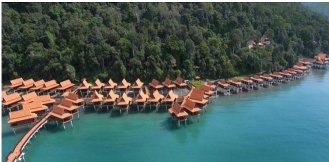
Foto 5: Pembangunan chalet atas air di pesisiran pantai (Berjaya Langkawi Resort, Pulau Langkawi, Kedah)
