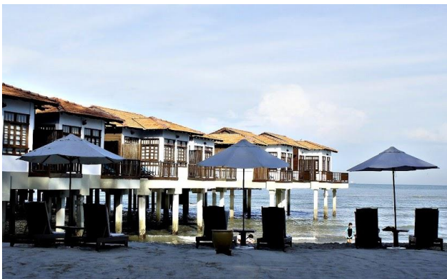
Foto 12: Pembangunan chalet atas air seharusnya tidak menghalang pemandangan ( views dan vista ) oleh orang awam
