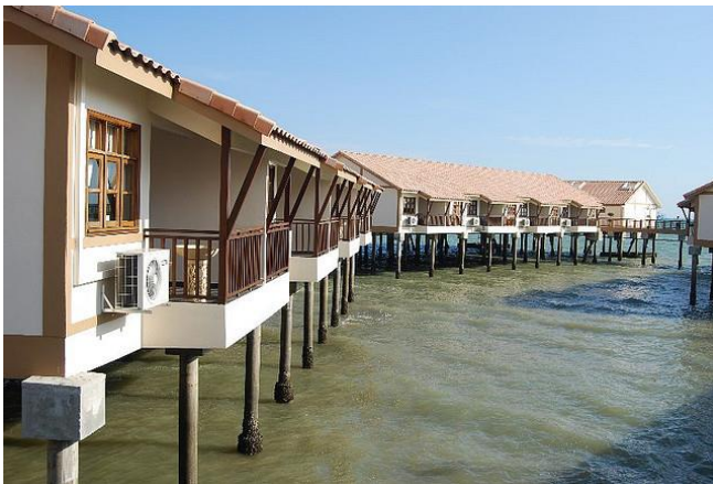
Foto 7: Pembangunan chalet atas air di pesisiran pantai yang dibina di atas tiang ( stilt ) (Hotel Grand Lexis, Port Dickson, Negeri Sembilan)
