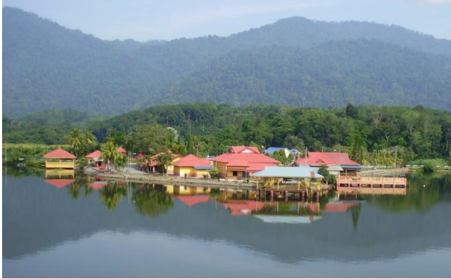
Foto 6: Pembangunan chalet atas air di tasik (Resort Tasik Raban, Lenggong, Perak)
